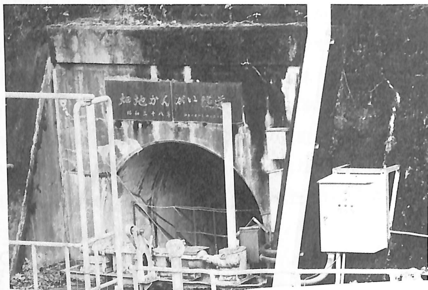
取水口（沼本ダム）
