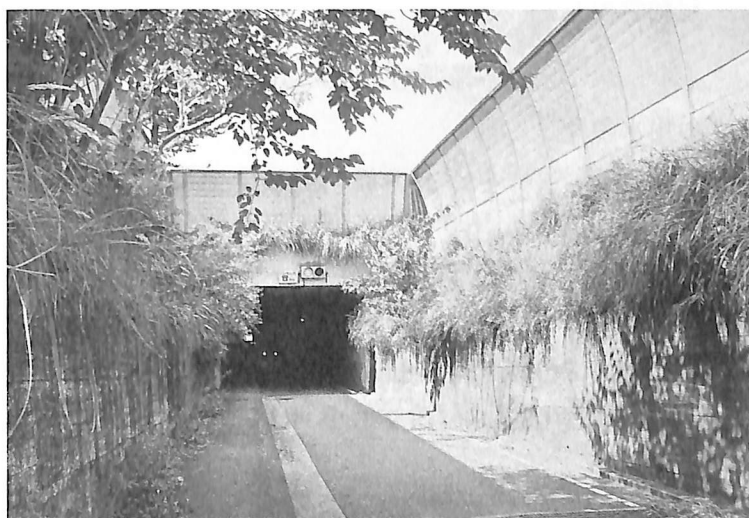
新戸トンネル
